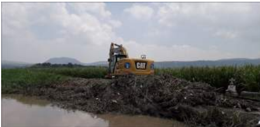
Figura 8. 2. Trabajos de desazolve de canales de la Laguna de Atotonilco (Fuente: J. de Anda-Sánchez, 2021, elaboración propia)
