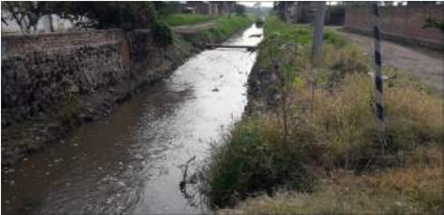
Figura 6. 5. Vista aguas abajo del canal C2 localizado en Atotonilco el Bajo (Fuente: J. de Anda-Sánchez, 2021, elaboración propia)
